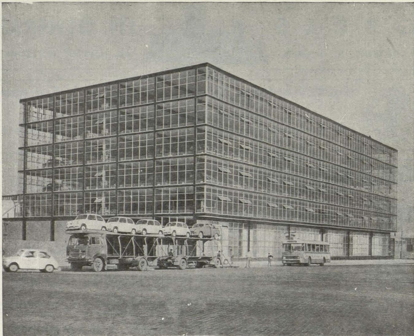
Magnífica combinación de aluminio y cristal nos ofrece el edificio de la empresa S. E. A. T. en Barcelona. Toda la fachada está cerrada con carpintería de aluminio montada sobre estructura de acero.
